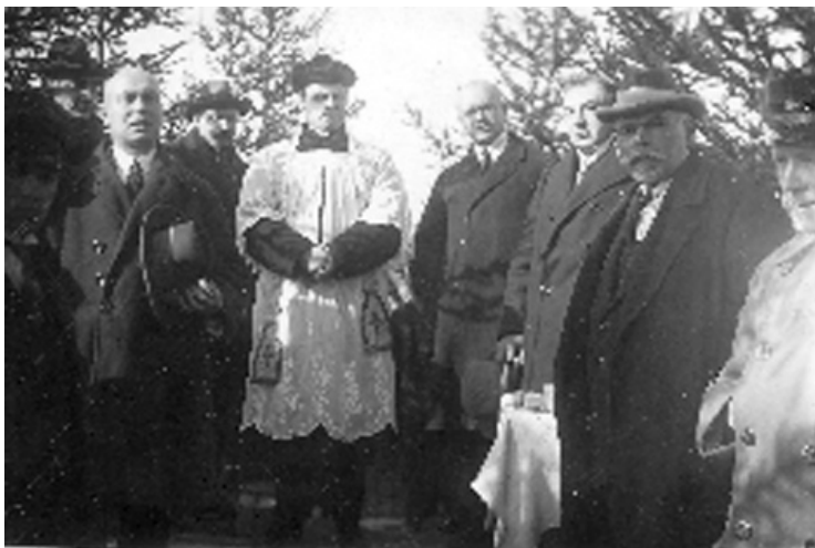
1925. gads. Skolas pamatakmens iesvētīšana. Skolas pamatakmeni iesvētīja Ilūkstes katoļu draudzes prāvests A. Āboltiņš. Otrais no labās: būvdarbu vadītājs Iļjabs.
