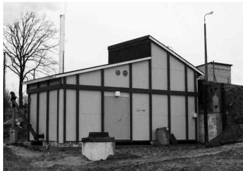
Jaunuzcēta konteiner-tipa katlu māja
