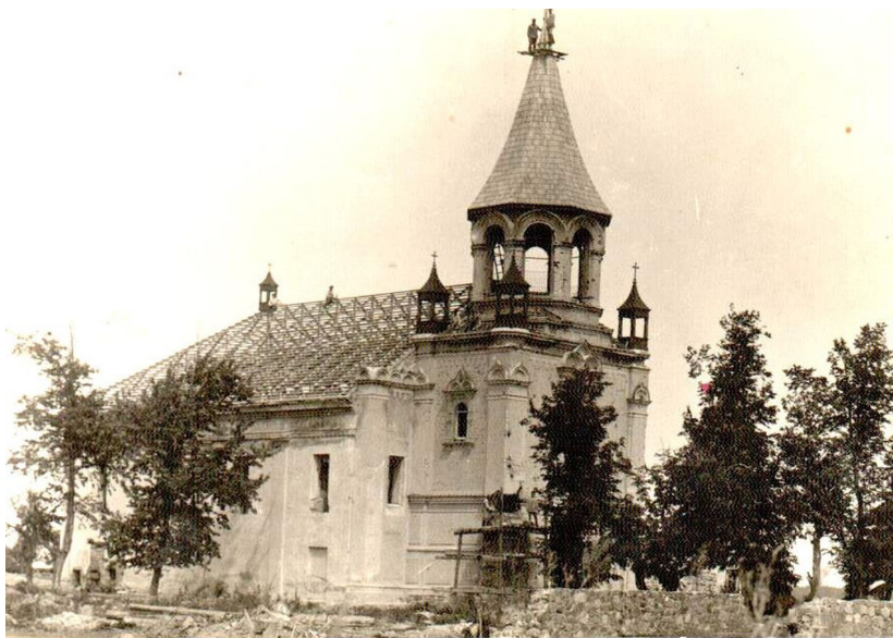
Ilūkstes Romas katoļu baznīcas remontdarbi, 1938.-1948. gads
