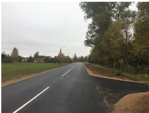
2018.gadā tika īstenots ERAF projekts “Ieguldījums komercdarbības attīstībai Ilūkstes novadā”, kura ietvaros tika veikta Strēlnieku ielas posma atjaunošana, lai attīstītu uzņēmējdarbību un uzlabotu piekļuvi ražošanas apbūves teritorijai Ilūkstes pilsētā
