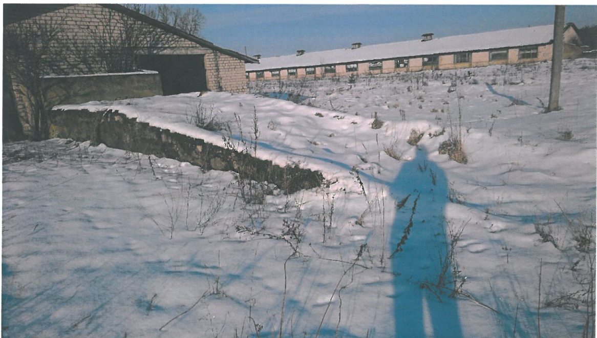
3.attēls. Esošā būve, kuru plānots demontēt.
